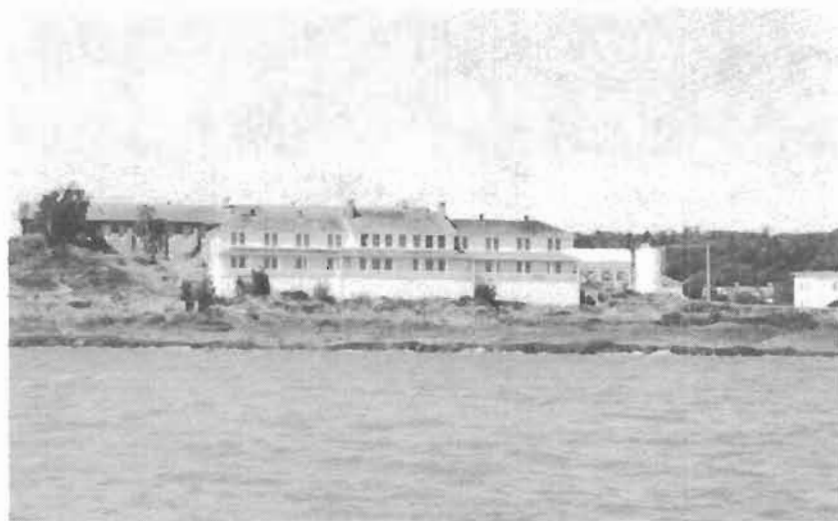
Bloc du « centre » et résidence du personnel.
