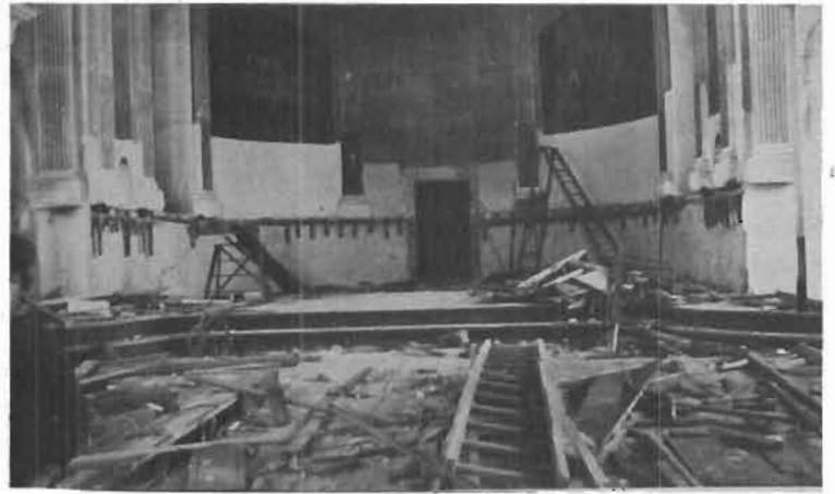
Ruines à l'intérieur de l'Eglise après le tremblement de terre de 1925
