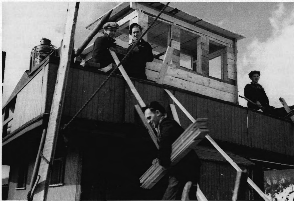
Un chantier maritime à Petite-Rivière-Saint-François
