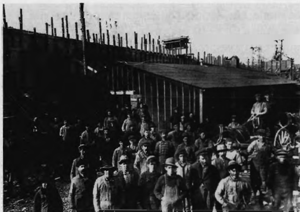
Les ouvriers travaillant à la construction de l'usine Donohue de Clermont, en 1911 Photo : Inconnu. Société d'histoire de Charlevoix
