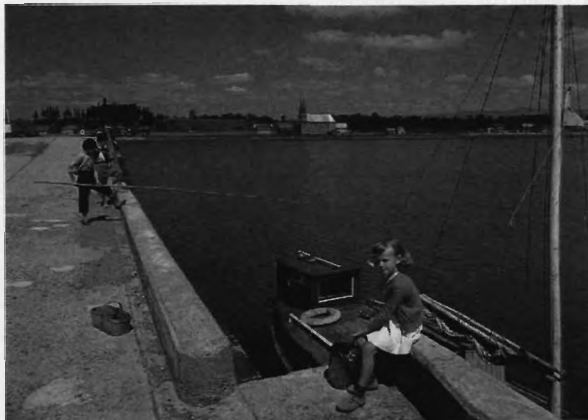
Le village de Saint-Louis-de-l'Île-aux-Coudres vu du quai Photo : O.F.Q. Cote : E6, S7, P249-55. Archives nationales du Québec, Québec
