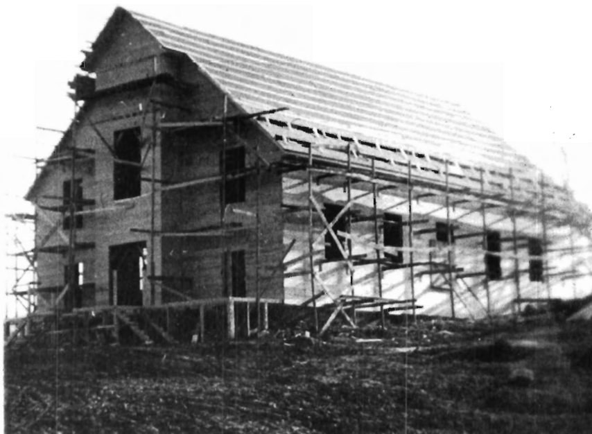
L'église en construction - Automne 1941
