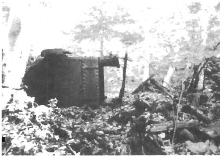
Figure 6: Bouilloire horizontale à vapeur originellement attachée à un ouvrage en bois et maçonnerie de 2 mètres par 4 mètres. L'ouvrage est fortement dégradé et devra être consolidé pour supporter à nouveau le mécanisme. (86.D48.11)
