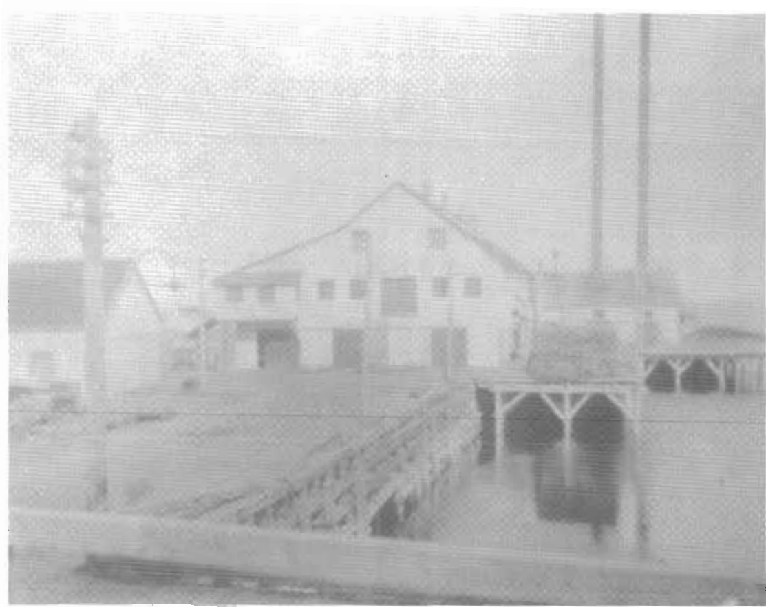
Photo prise en 1905. La Cie Price bâtit dans l'Anse un gros moulin, fonctionnant jour et nuit, l'électricité étant fournie par un gros ruisseau.
