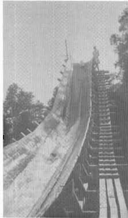
Vers 1920, les Pellington reçoivent de la Cie Price, suite à un feu, une coupe de bois. La dalle partait du Petit-Sault jusqu'au quai de l'Anse. Les barges à vapeur transportaient jusqu'à 1400 cordes de bois par voyage.
