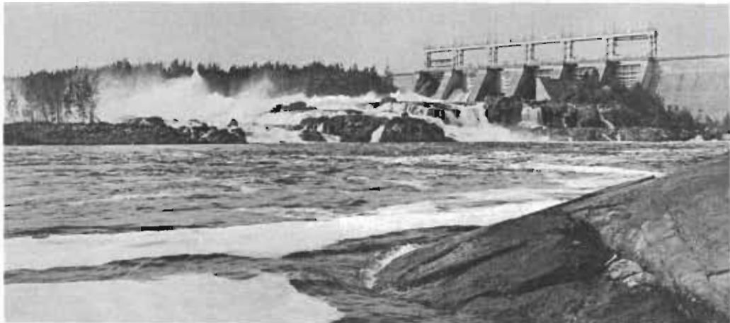
Le barrage de Chute-à-la- Savane.
