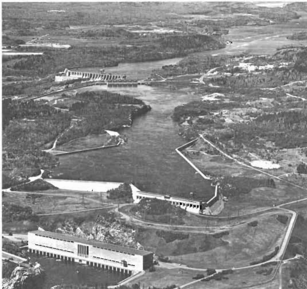
Une partie du réseau hydro-électrique de l'Alcan: Shipshaw et Chute-à-Caron.
