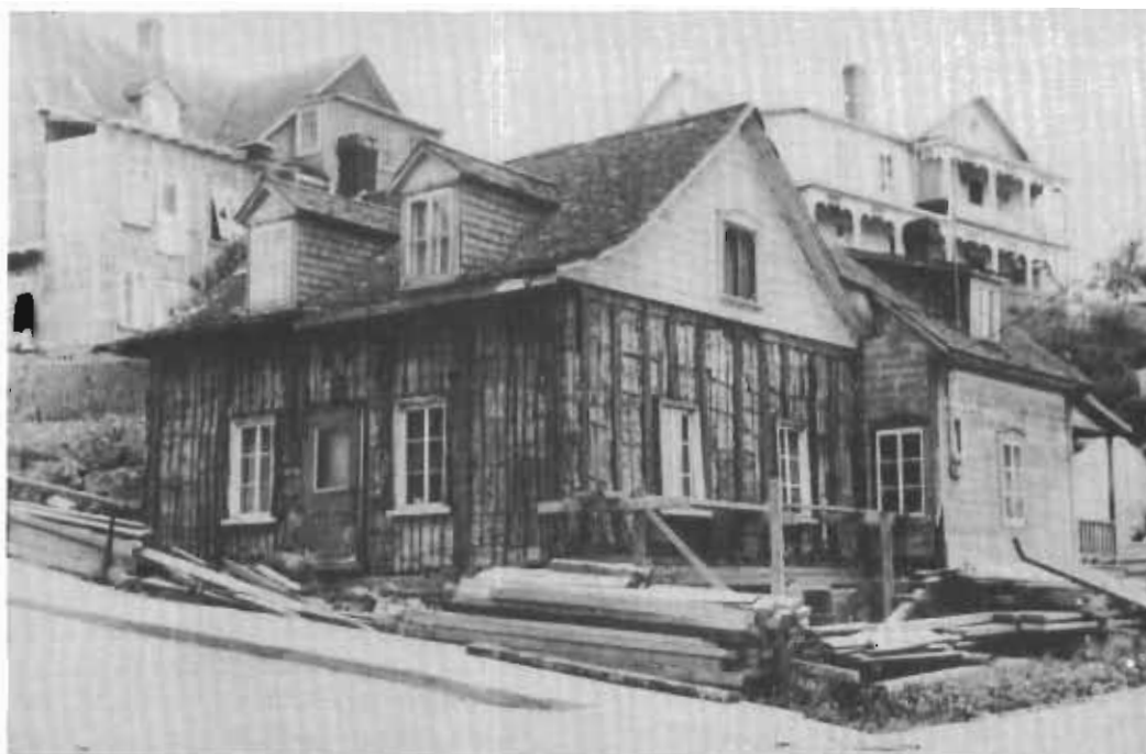
Maison ancestrale à Bagotville. À remarquer le revêtement d'écorce de bouleau faisant office d'isolant thermique.
