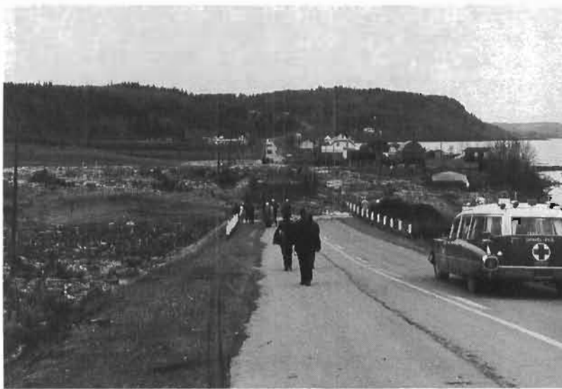
Le pont des Terres-Rompues ne résiste pas à la formidable pression exercée par la rivière de boue qui balaie tout sur son passage. Photo: Raymond Blanchette, service audio-visuel, UQAC.
