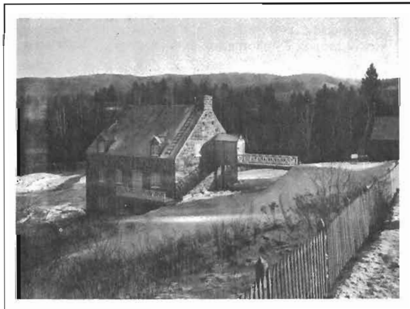
Le moulin du Père Honorat après la restauration.
