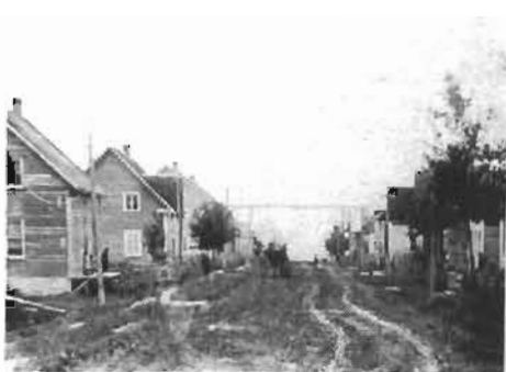
Vue du Village Nord-Sud
