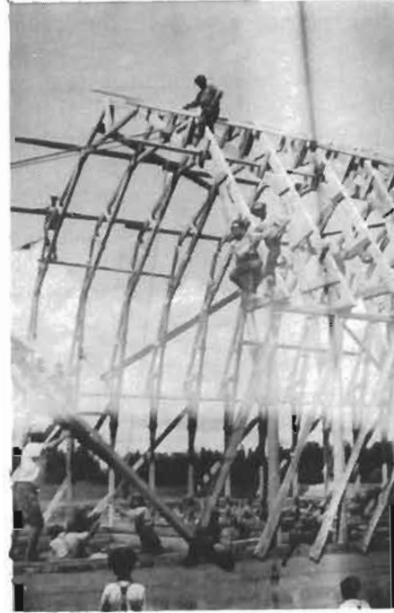
Montage d'une charpente
