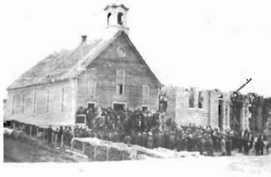
Commencement de la construction de l'église de pierre
