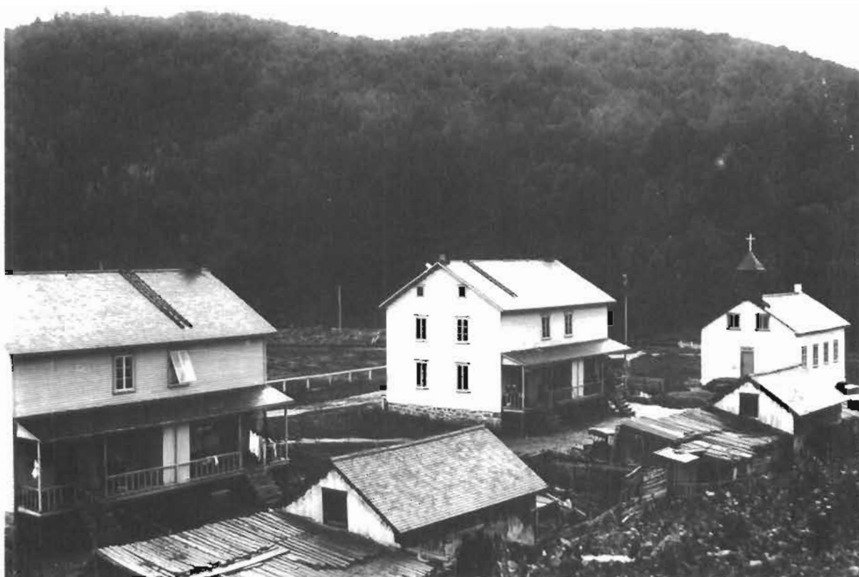
Habitations et première chapelle de Val-Jalbert. Ces bâtisses avaient été construites face à l'usine.
