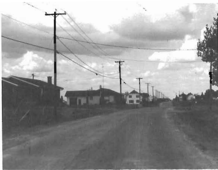
Vue d'une partie du Rang 3 Nord.
