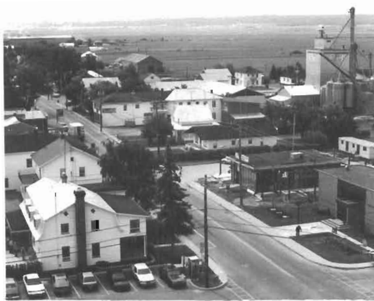
Le coeur du village (vue de l'église) avec ses bâtiments de services et les installations de la Coopérative agricole.
