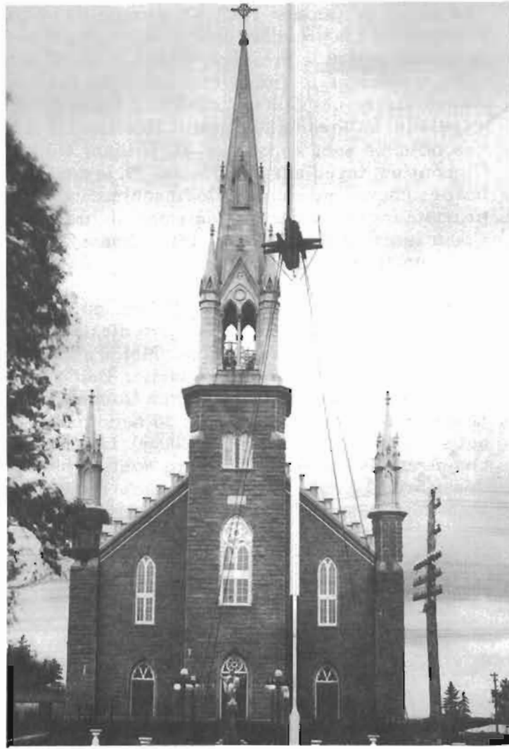
A l'aide de treuils, on procède à l'installation des paratonnerres sur le toit de l'église. (1920)
