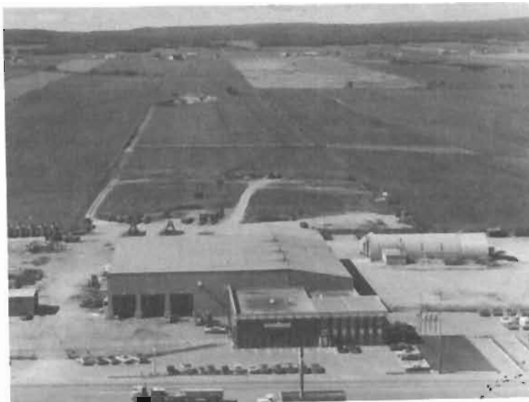
L'envergure des Industries Tanguay a dépassé nos frontières depuis nombre d'années (vue des installations en 1978).
