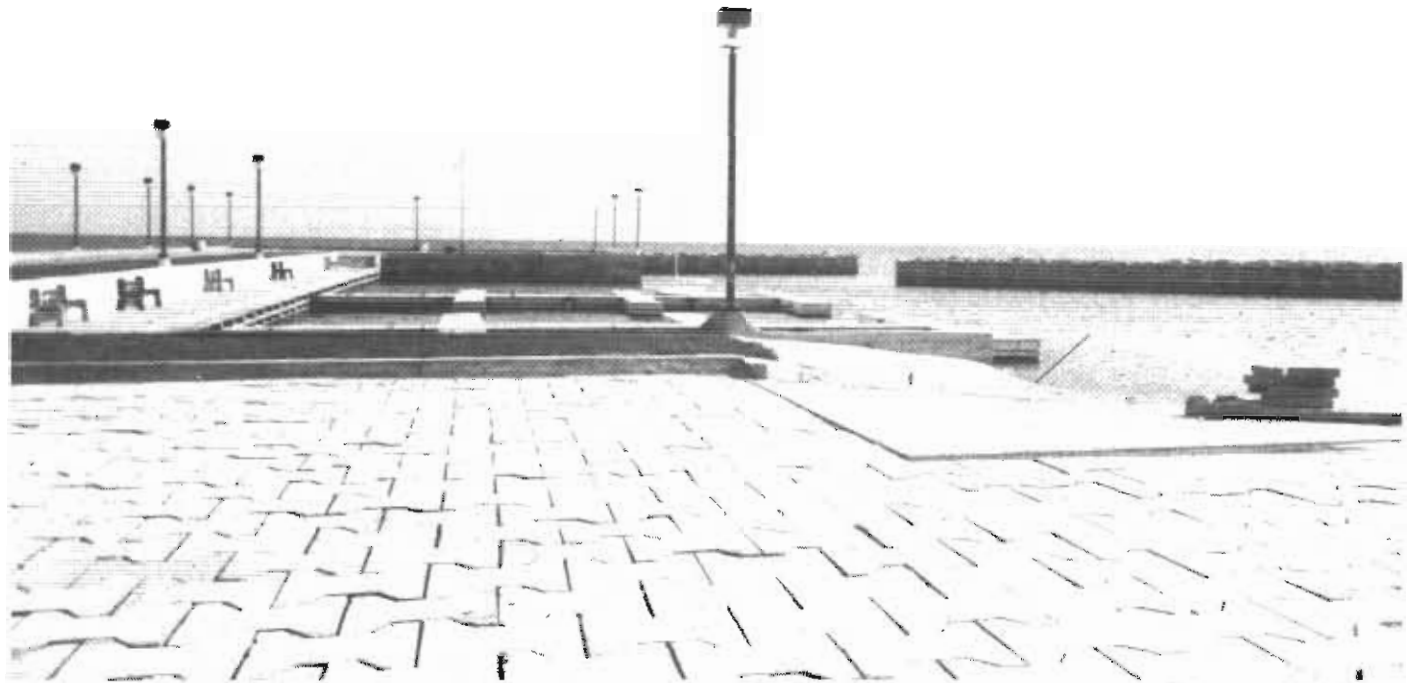
SUPERBE : Cette marina a été construite à partir des structures de l'ancien quai municipal de Saint-Prime et réalisée au cours des dernières années.
