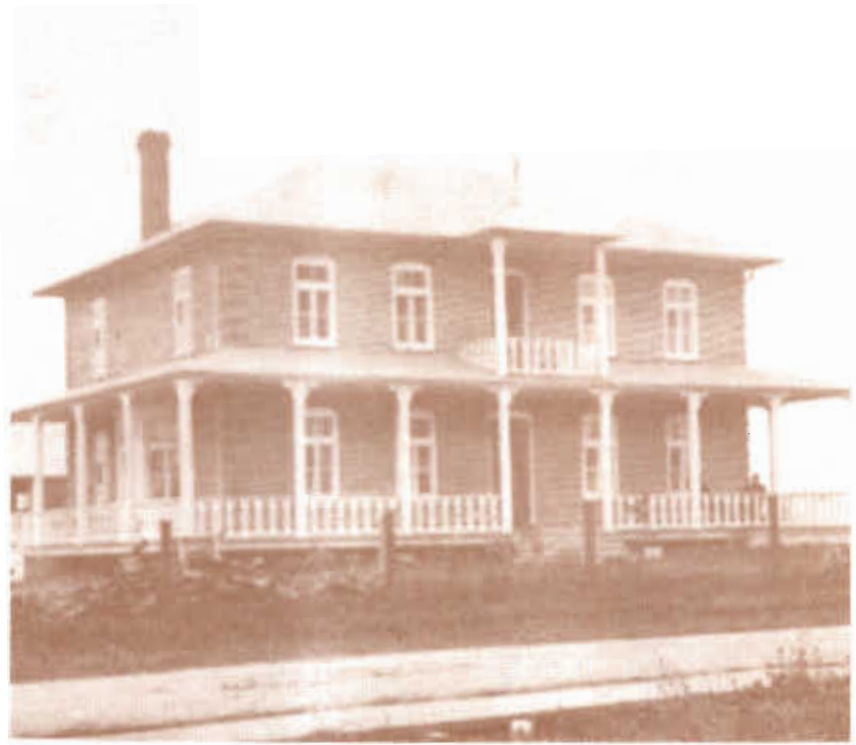
Le presbytère de Saint-Prime, construit en 1914.
