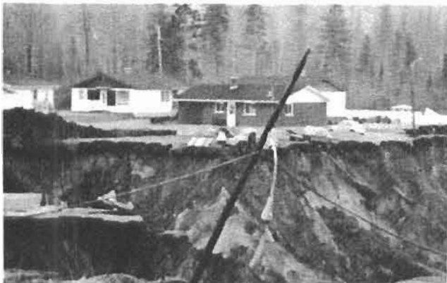
Glissement de terrain à Saint-Jean-Vianney
