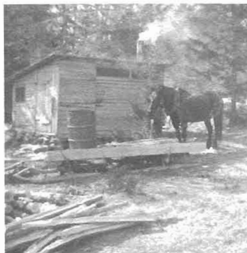
Dans les chantiers
