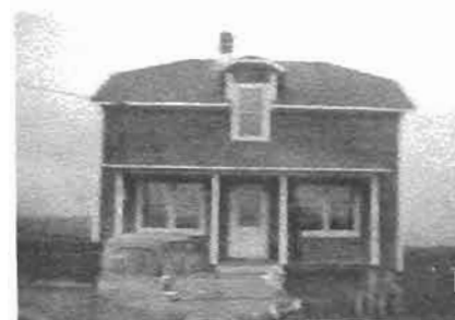
2 e maison construite par Émile Fortin (1951)
