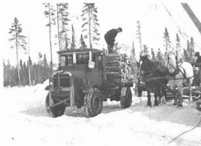
Au chantier à Hearst, Ontario
