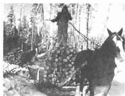
Gérard au chantier
