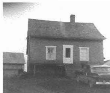
La maison familiale et ses bâtiments dans les années 1920
