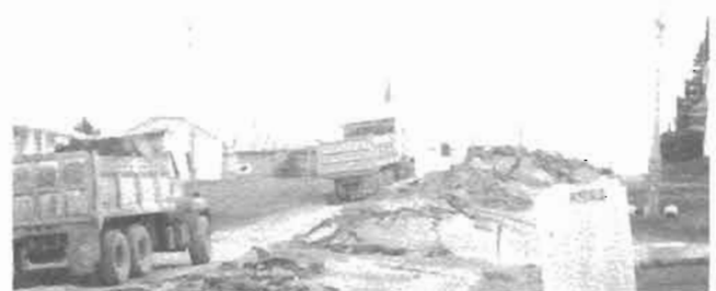
Travaux de voirie
