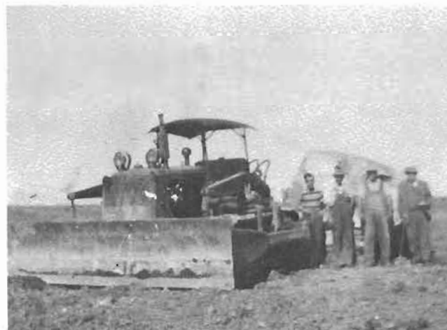
Le premier bulldozer dans la région (1947) acheté par Raymond Pomerleau et Émile Charpentier au prix de 14 000 $. Emprunt 1000 $ de Joseph Shink pour le comptant, et la balance par paiement
