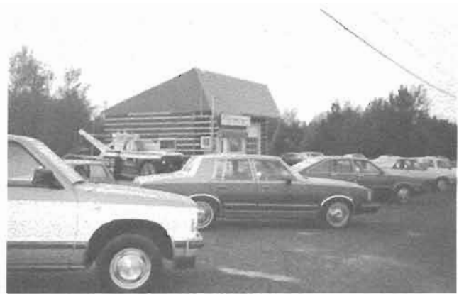
2 e garage en construction, en 1987
