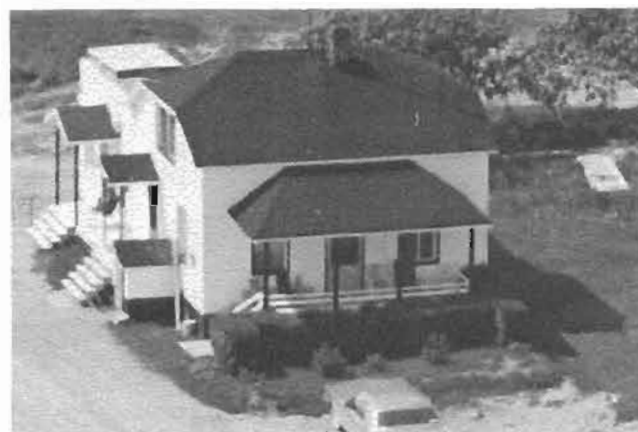
Résidence familiale bâtie en 1940, rénovée en 1965
