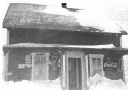
Leur habitation détruite par un incendie
