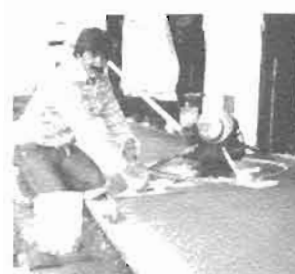
Maurice et son équipement de finisseur de ciment
