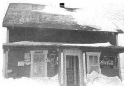
Leur habitation détruite par un incendie
