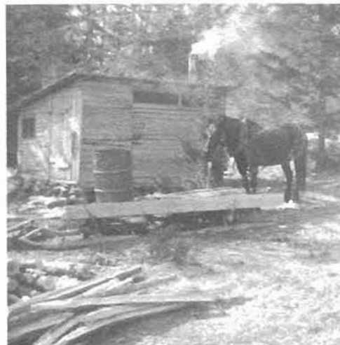
Dans les chantiers
