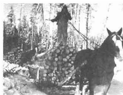
Gérard au chantier
