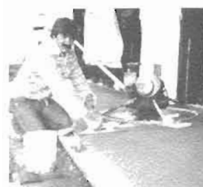
Maurice et son équipement de finisseur de ciment
