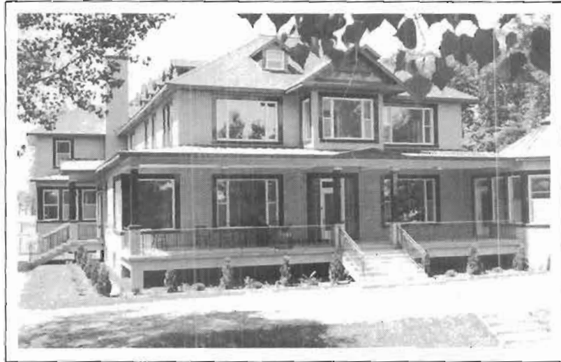
Le presbytère de St-Félicien, qui a été construit en 1954.
