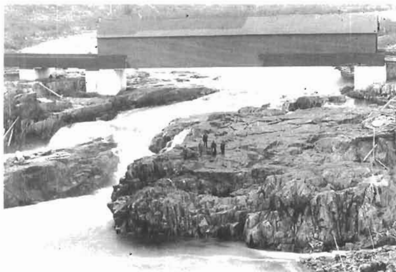
Le vieux pont couvert de Saint-André. Photo: coll. ANQC, fonds SHS, no 10 638.
