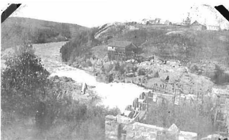
Une vue des fondations de la pulperie et du village. Photo: coll. ANQC, fonds SIIS, no 9 575.
