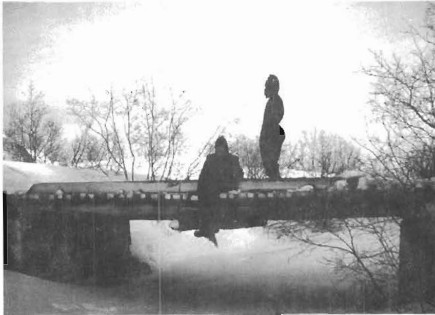
En hiver, sur le pont à la Chute-des-Dionne (maintenant démoli).
