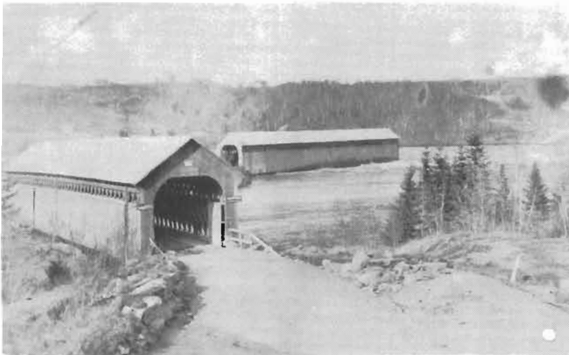
Le Pont de Taché après que la partie nord eût été emportée par les flots.
