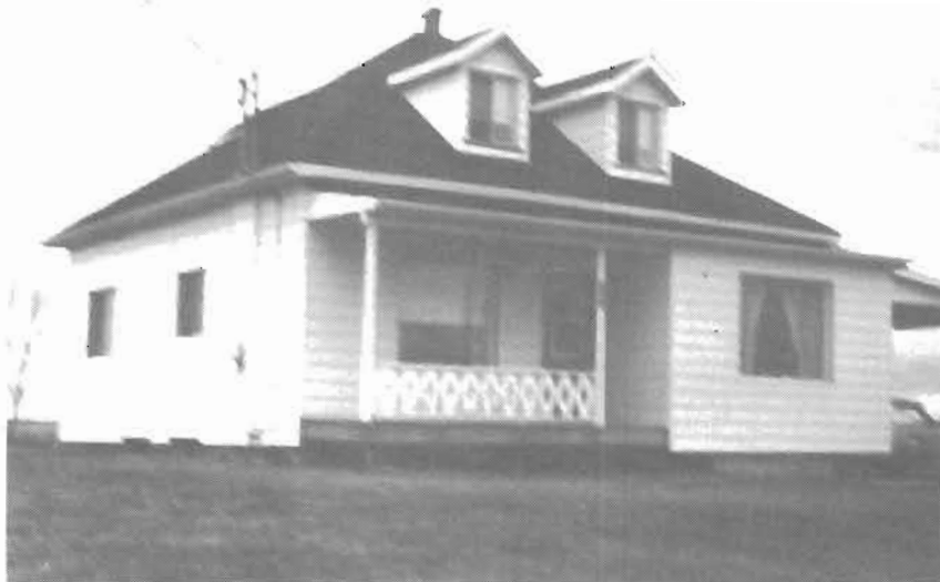
L'école n° 9 du Rang V, reconstruite en 1947 pour remplacer celle qui avait été incendiée l'année précédente. Cette école, construite par deux maîtres-charpentiers, Edgar Bouchard et Salomon Maltais, était d'un style bien différent des écoles construites auparavant; elle avait même un solage en béton de 6 pieds de hauteur. Il faut noter que les lucarnes, la galerie et la véranda ont été ajoutés par le propriétaire actuel, M. Raymond Larouche, du Rang St-Dominique. Le coût de construction de l'école avait été de $ 5,700.
