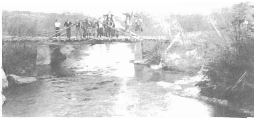
Le pont construit à la Chute-des-Dionne.
