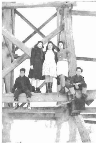
Le "tracel" construit sur la terre de Ludger Plourde, dans le Rang 5 et qui devait servir pour le chemin de fer vers Chibougamau; il fut démoli en 1944.
