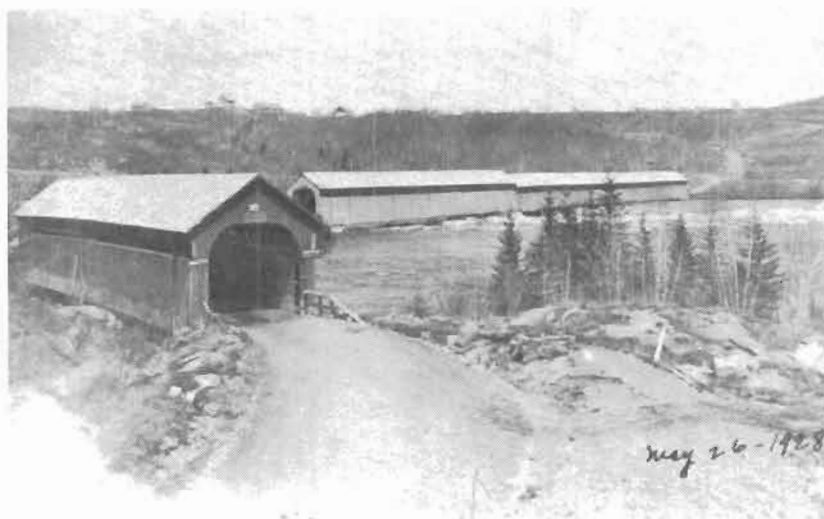
Le 26 mai 1928, lors de la crue des eaux.
