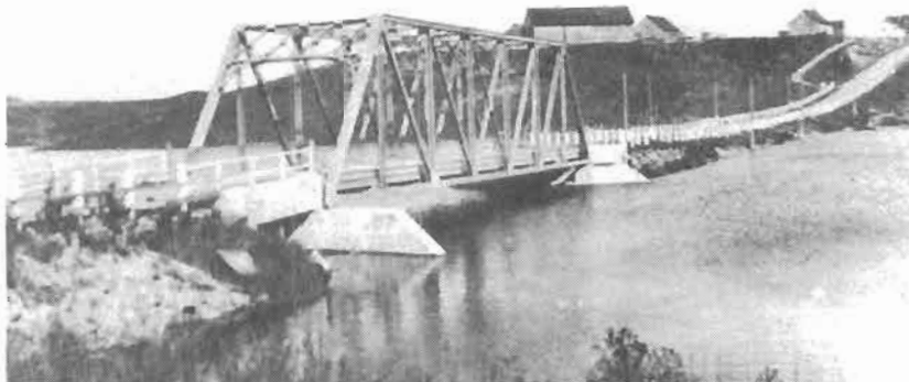
Le pont de fer sur la Rivière-aux-Harts, remplacé par un pont en béton, en 1968 et construit par la firme Roméo Fortin Inc., d'Alma.
