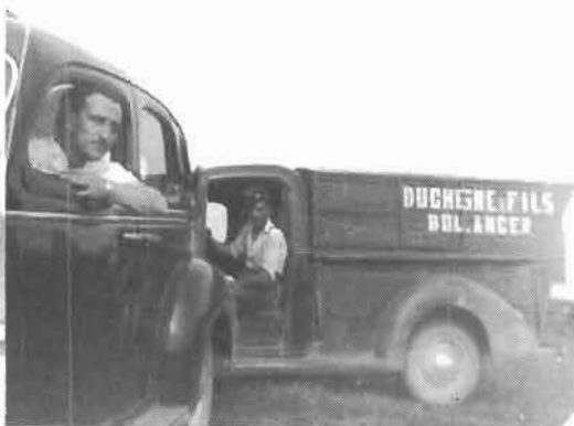
Edmond Duchesne, conducteur du camion de la boulangerie.
