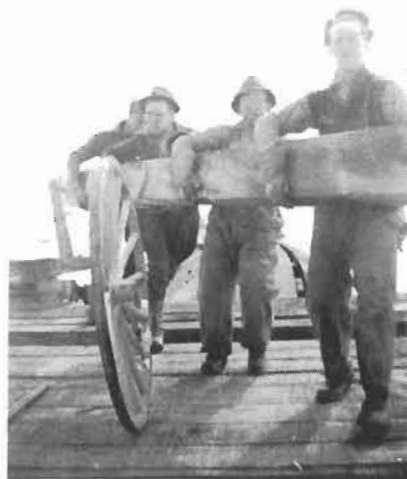
Démolition du trachel du chemin de fer de Chibougamau, en 1940, au moyen d'un moulin à scie portatif. Sur la photo, Joseph Brisson, Francis Brisson et Philippe Gilbert.
