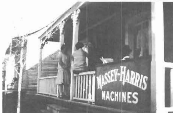
La maison de François Bergeron, vendeur de machines agricoles.
