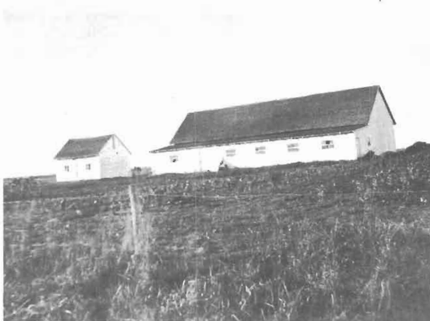
La "soue" et la grange appartenant à Eugène Maltais. L'étable est devant la grange, dans la partie en pente douce (style plutôt rare en 1935).
