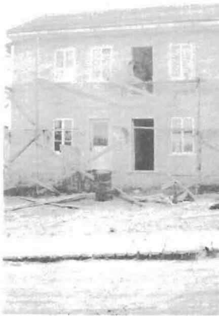
La maison de Ferdinand Larouche, construite en une semaine, grâce à une corvée.
