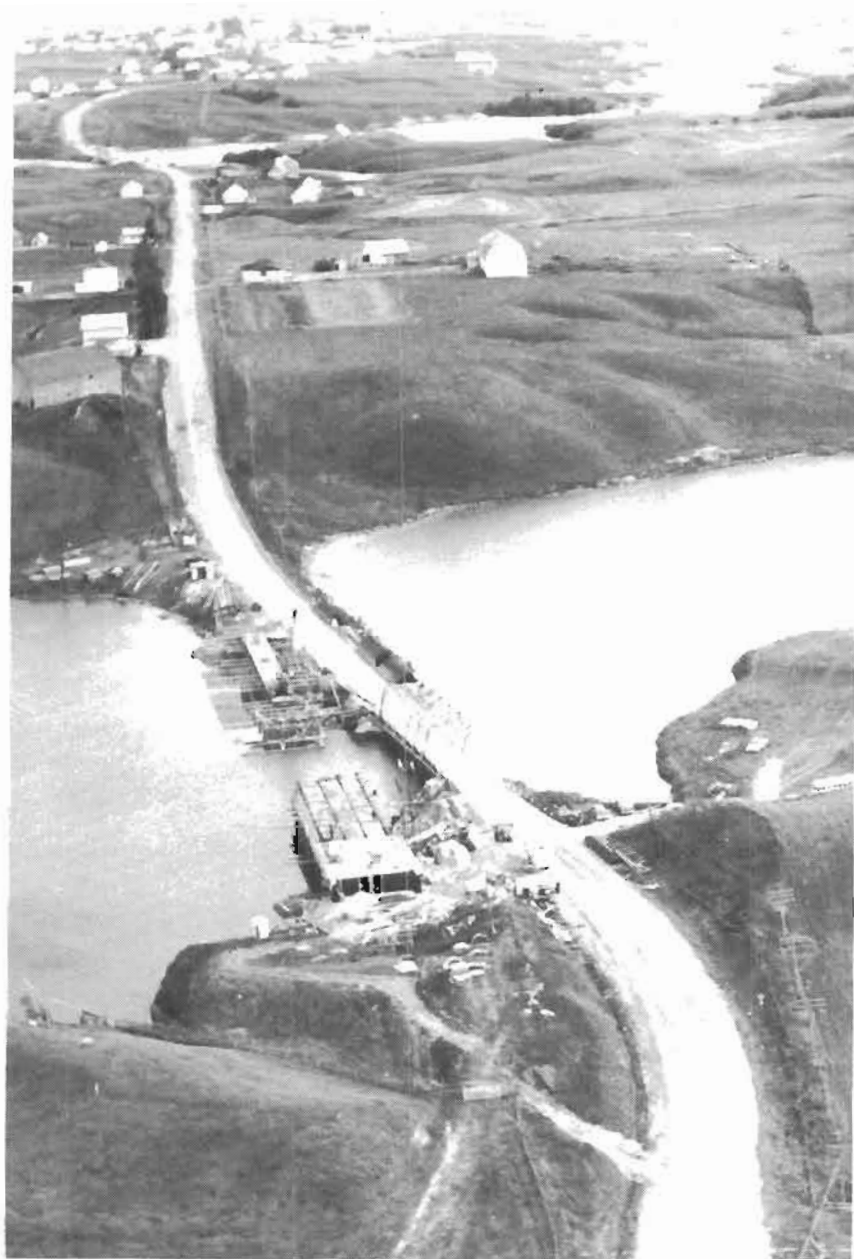
Le pont sur la Rivière-aux-Harts, pendant la construction en 1968; le contrat a été exécuté par la firme Roméo Fortin Inc. d'Alma et la compagnie Sud Ltée, de Montréal.
