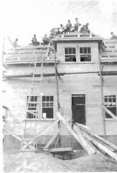
La deuxième maison de François Gilbert, construite en 1940, à la corvée.
