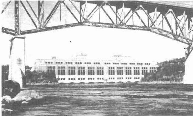
Le pont actuel qui relie les côtés nord et sud de la Grande-Décharge. À l'arrière-plan, la centrale hydro-électrique d'Isle-Maligne.
