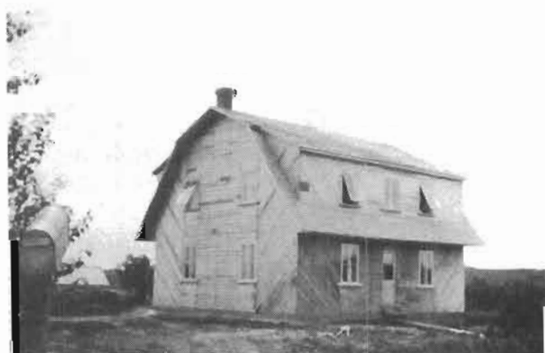
Sa deuxième maison construite en 1931.
