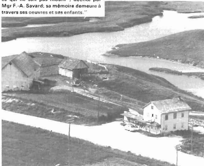
La fromagerie construite par Eugène Bergeron dans le rang Saint-Georges (Rang des Chicots). Au moment de la prise de cette photo, la fromagerie, à côté de la maison, était en démolition.
