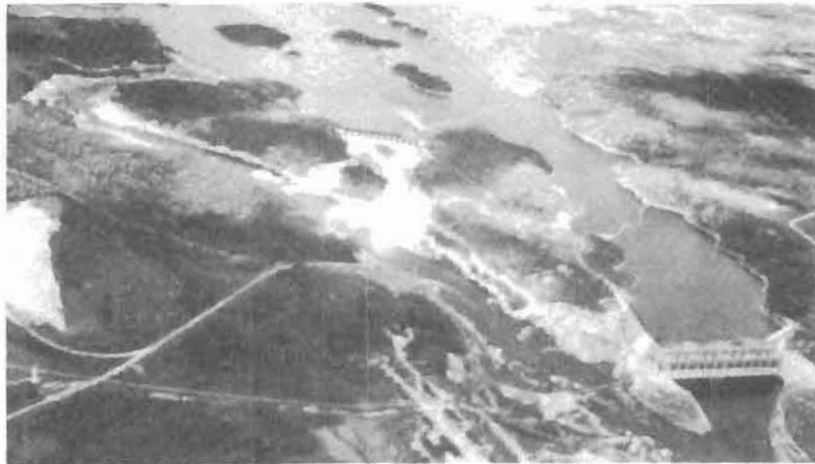
Panorama des barrages de la Grande-Décharge.
