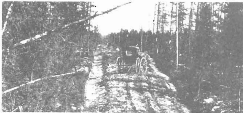
Ouverture d'un chemin de colon.
