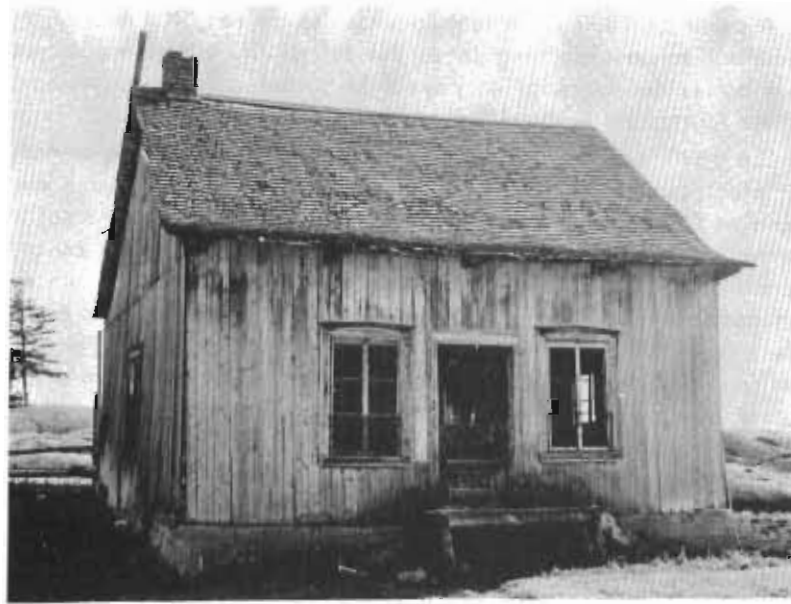
Ecole du rang IX construite en 1887. (Photo 1967)
