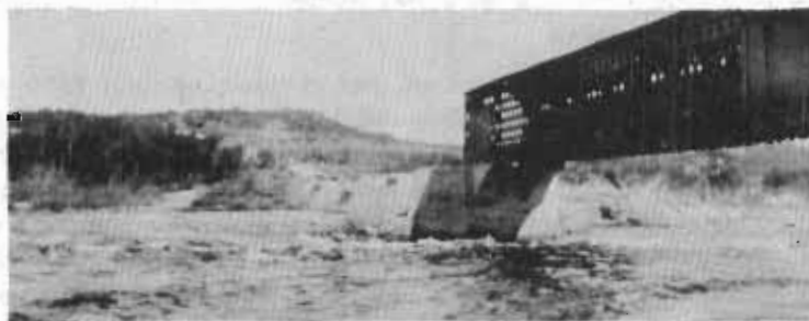
Le pont de Taché. — Détail de la structure de la grande arche.
