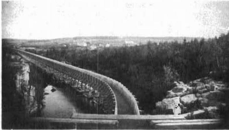
La "dalle" à sa partie supérieure
