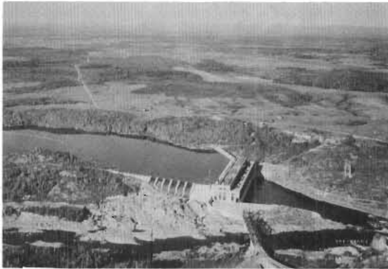
Centrale de l'île Maligne
