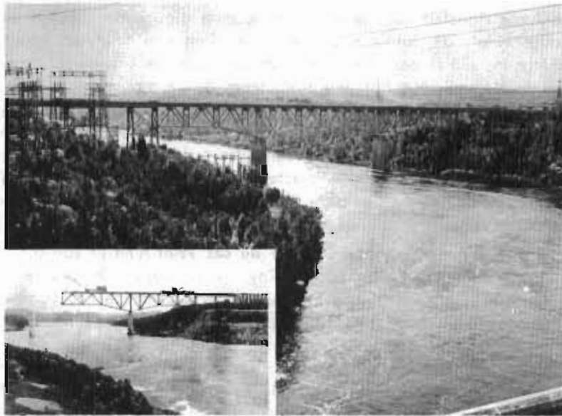
Pont de fer sur la Grande Décharge
