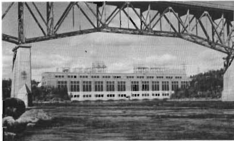
Centrale hydroélectrique de l'Isle-Maligne
