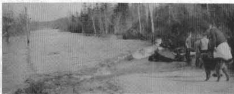
La route inondée aux approches du pont.
