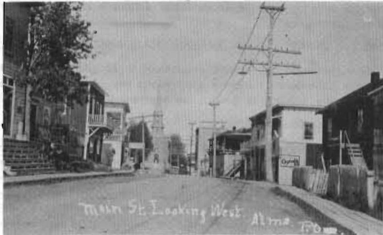
Rue Sacré-Coeur vue vers l'Ouest.
