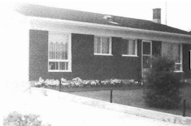
Maison familiale de Baie-Comeau
