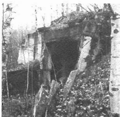
Vestiges du Moulin Fraser
