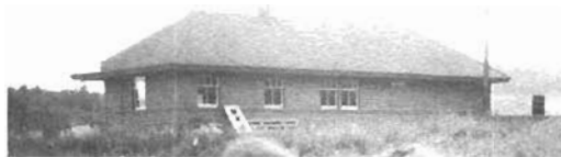
Première station à Saint-Marc
