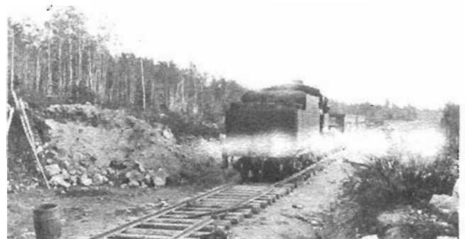
Construction du chemin de fer
