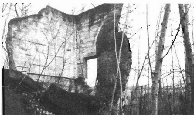
Vestiges du Moulin Fraser
