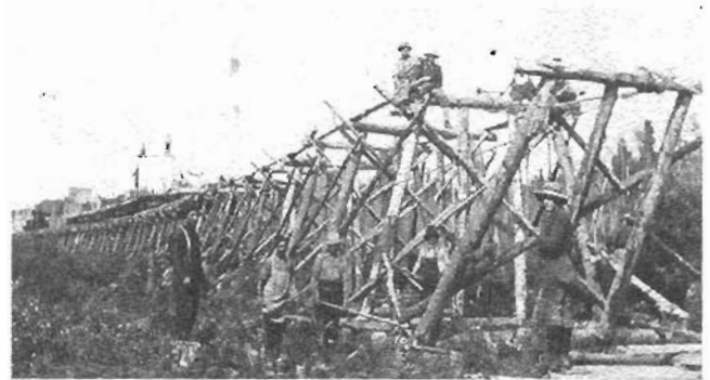
Construction du chemin de fer
