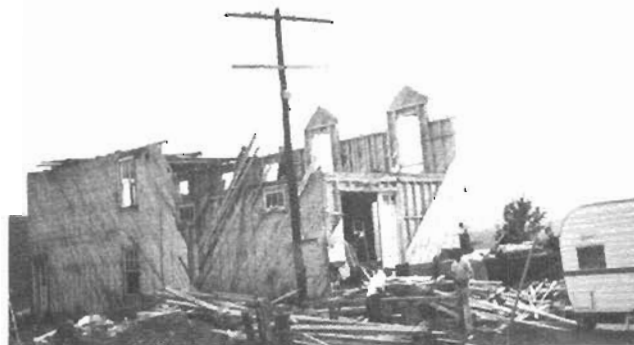
Démolition de la station
