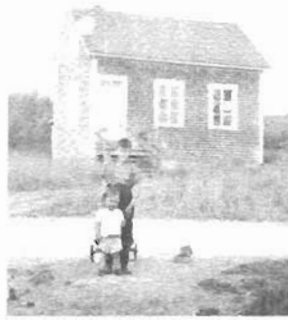
École de Bélanger Siding
