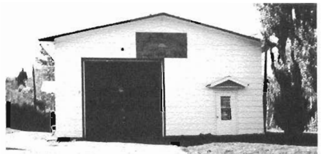
Caserne des pompiers
