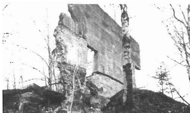
Vestiges du Moulin Fraser
