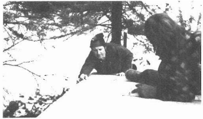
Construction du chalet de ski de fond. M. Adrien Kennedy avec un « Katimavik »
