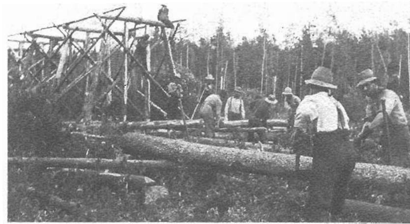
Construction du chemin de fer
