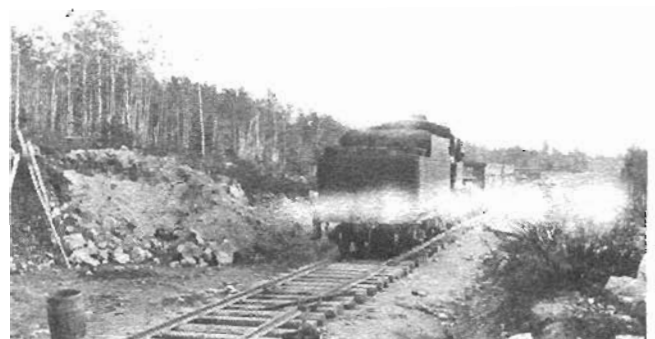
Construction du chemin de fer
