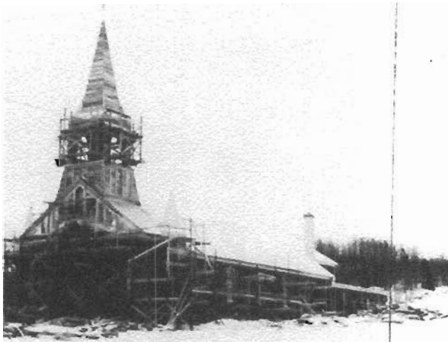
Construction de l'église actuelle
