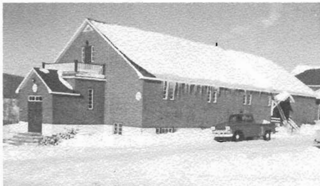
Première salle paroissiale à Saint-Marc
