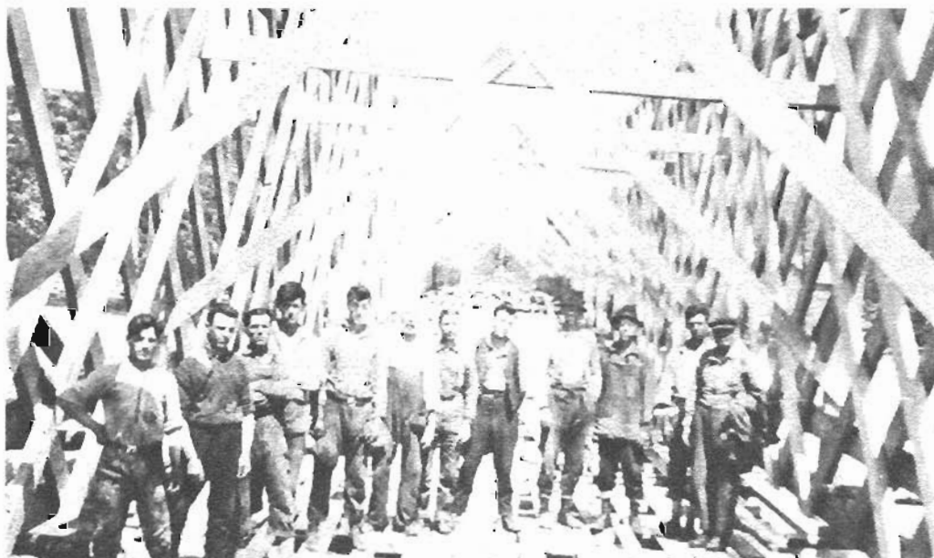
Construction du deuxième pont
