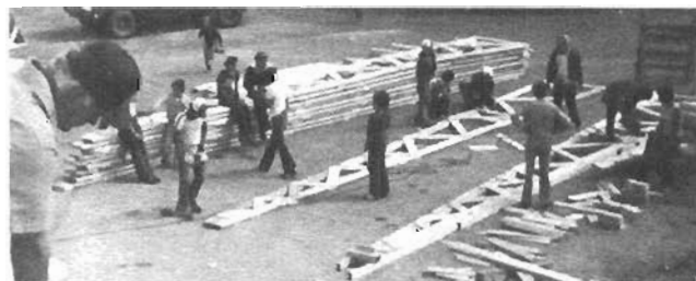
Corvée pour la construction du Centre communautaire
