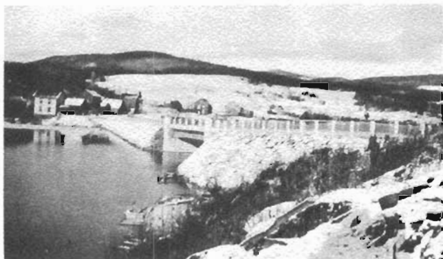
Pont actuel construit en 1939
