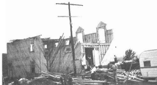
Démolition de la station
