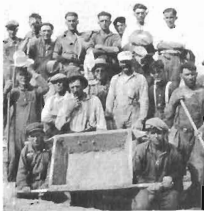
Hommes au travail à la construction de l'église.
