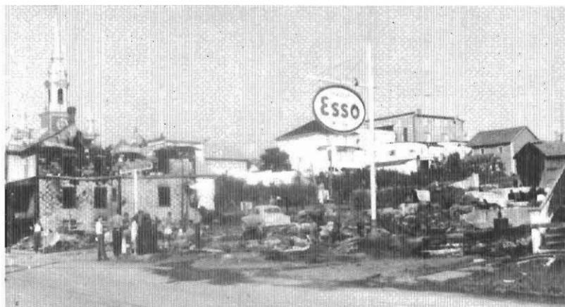
Débris du feu de 1962
