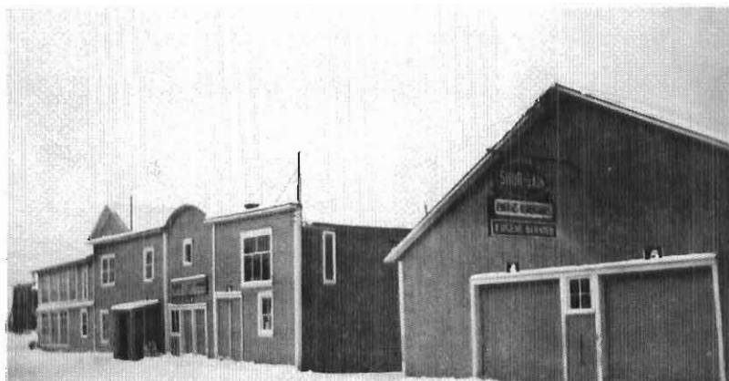
Entrepôts appartenant à Eugène Bernier en 1942.
