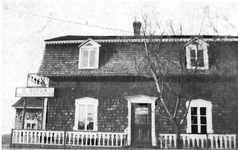
Maison de monsieur Ernest Rioux. Rodolphe y possédait son atelier pour son travail de ferblanterie.
