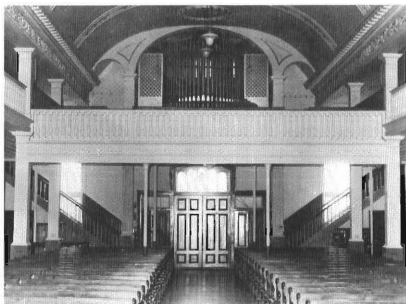
Vue intérieure de l'église: jubé et portique.
