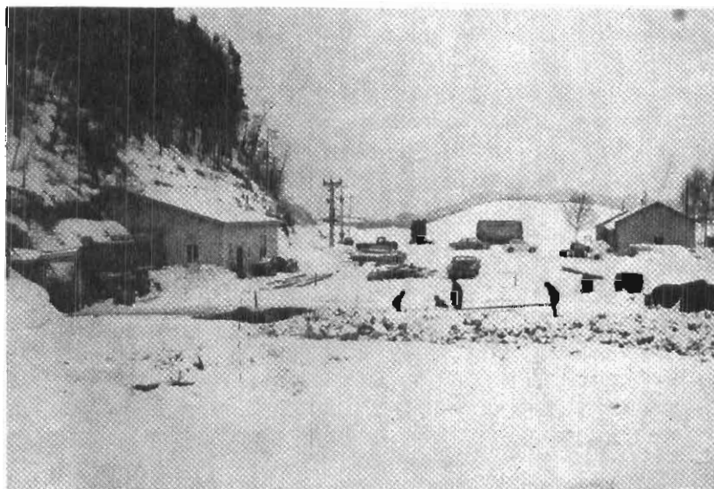
Sur les chantiers des Mines Roy & Ross Inc. en 1962.
