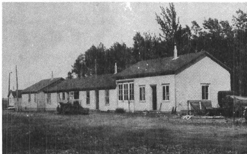
Aperçu des bâtiments des Mines Roy & Ross Inc.
