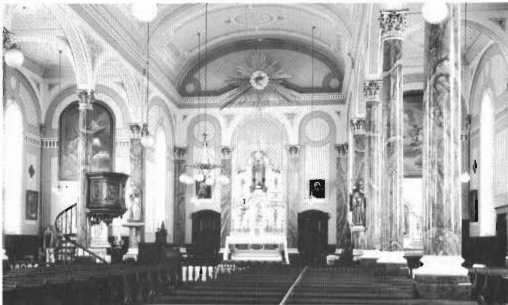
Intérieur de l'église après la 1ère restauration [1926].
