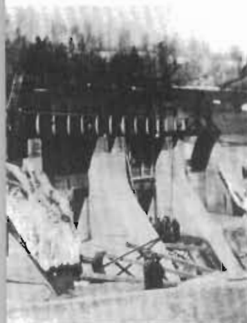
Le barrage sur la rivière Trois-Pistoles, à l'époque de la Compagnie électrique de Trois-Pistoles.
