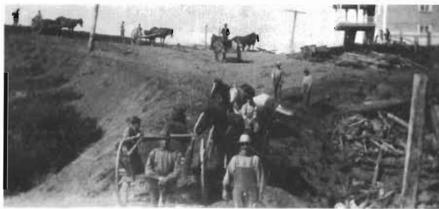
Travaux de voirie dans le rang 2 ouest de Trois-Pistoles.
