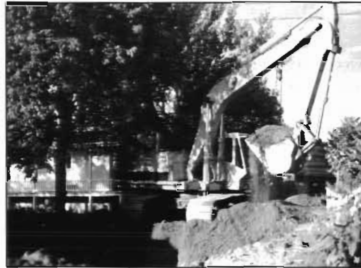
Travaux d'aqueduc et d'égouts, rue Jérémie-Beaulieu, 1981.
