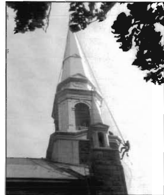
Travaux de restauration en 1977.
