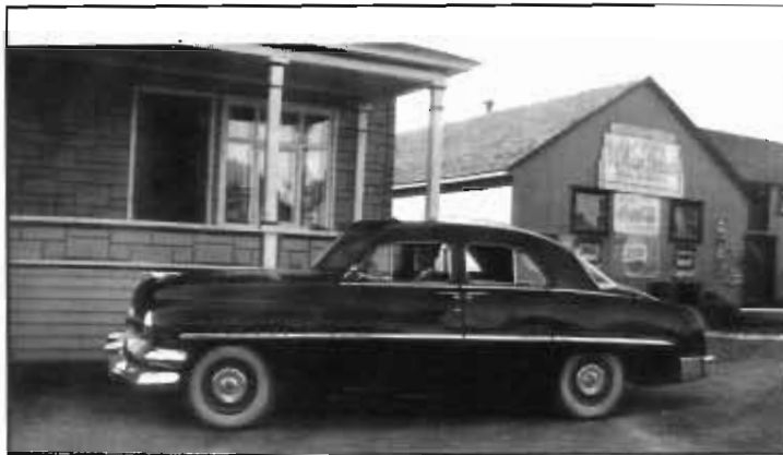
Maison de Thomas Gagnon. À droite, l'entrepôt de Hector Parent, 1951.
