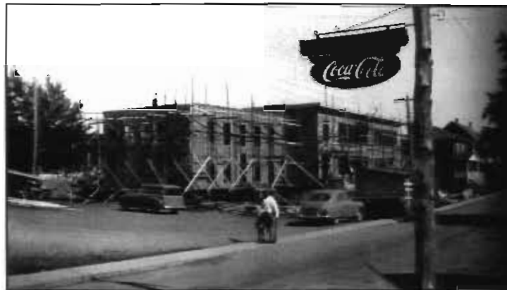
Construction du couvent, 1952.
