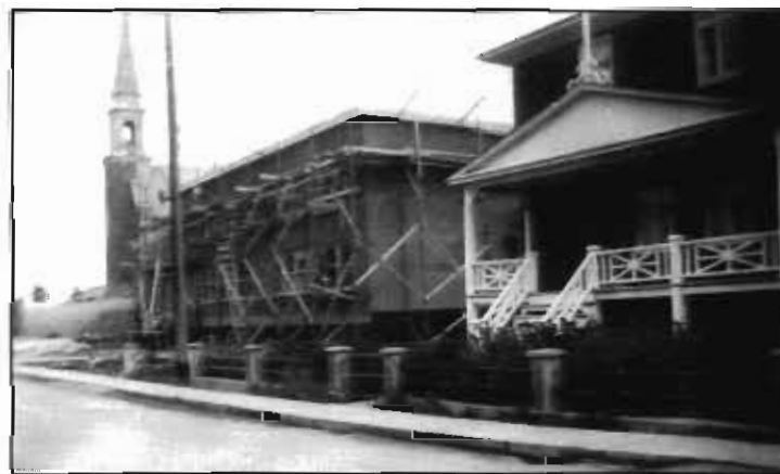
Construction du couvent, 1952.
