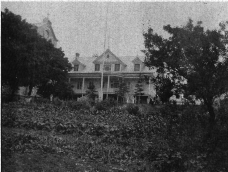
Le premier presbytère après sa restauration.
