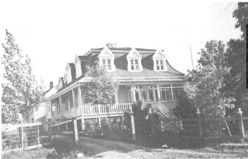
Le presbytère actuel construit en 1885.
