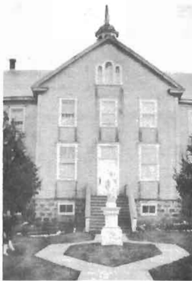
L'école Saint-Joseph, avant l'installation de la galerie à la façade.
