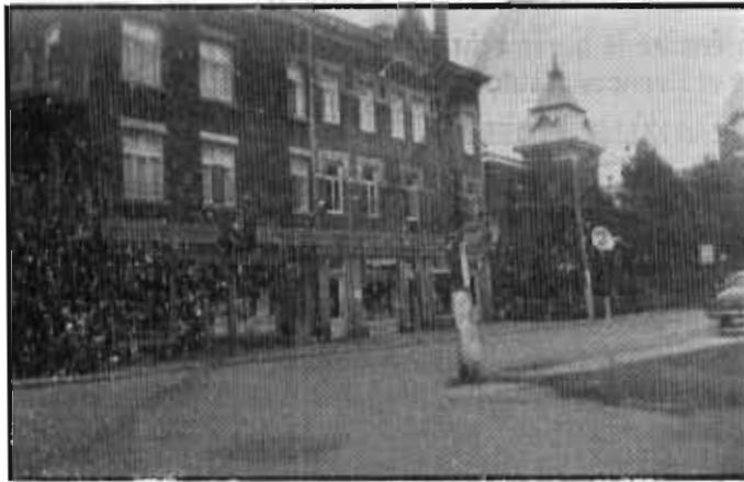
EDIFICES DESROSIERS PUIS BERGERON ET PALAIS DE JUSTICE
