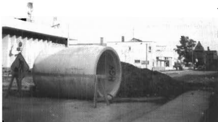
Travaux d'amélioration des égouts et d'aqueduc dans les secteurs des rues Soucy-Bon-Pasteur en 1971.
