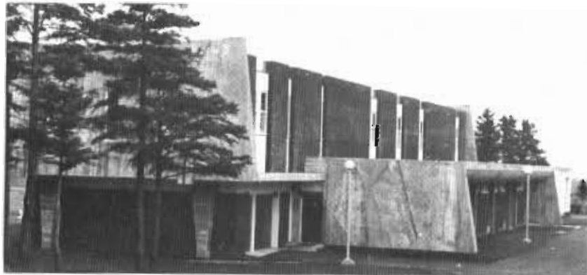
Résidence des Dames Ursulines construite en 1969.
