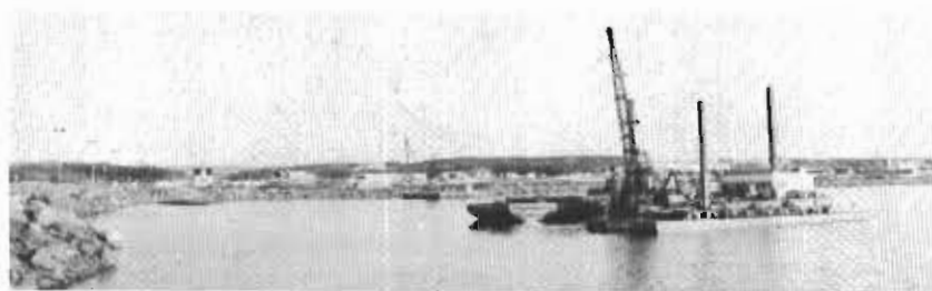
Travaux de construction du débarcadère ferroviaire en cours près de la jetée est du port de mer.
