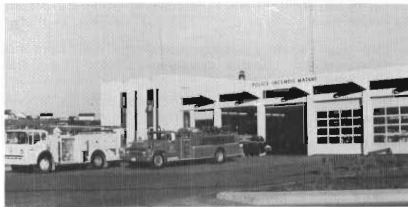
Service de Police et Incendie.
