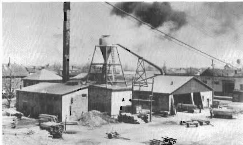
Vue d'ensemble des Installations de Gagnon & Frères.
