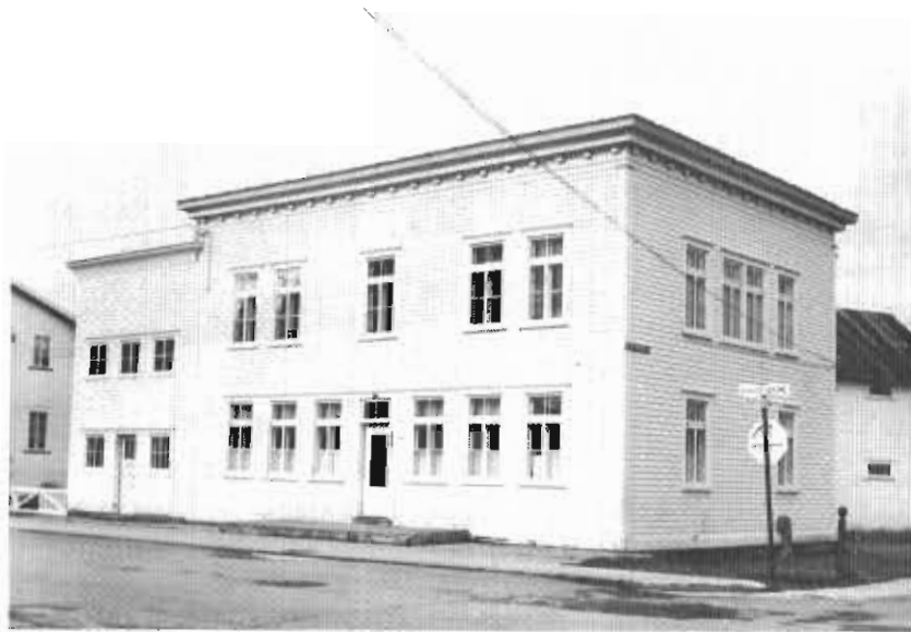
L'Ecole Price en 1961 dans l'ancien édifice à bureaux inoccupé depuis le départ de l'industrie Price Brothers en 1958. Cet édifice est présentement occupé par le Ministère du Tourisme, de la Chasse et de la Pêche.
