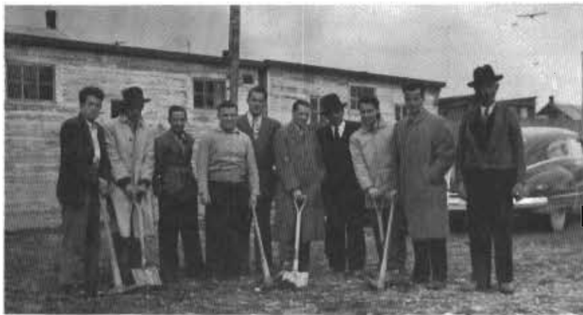
Début des travaux de construction de l'aréna de Matane en octobre 1945.
