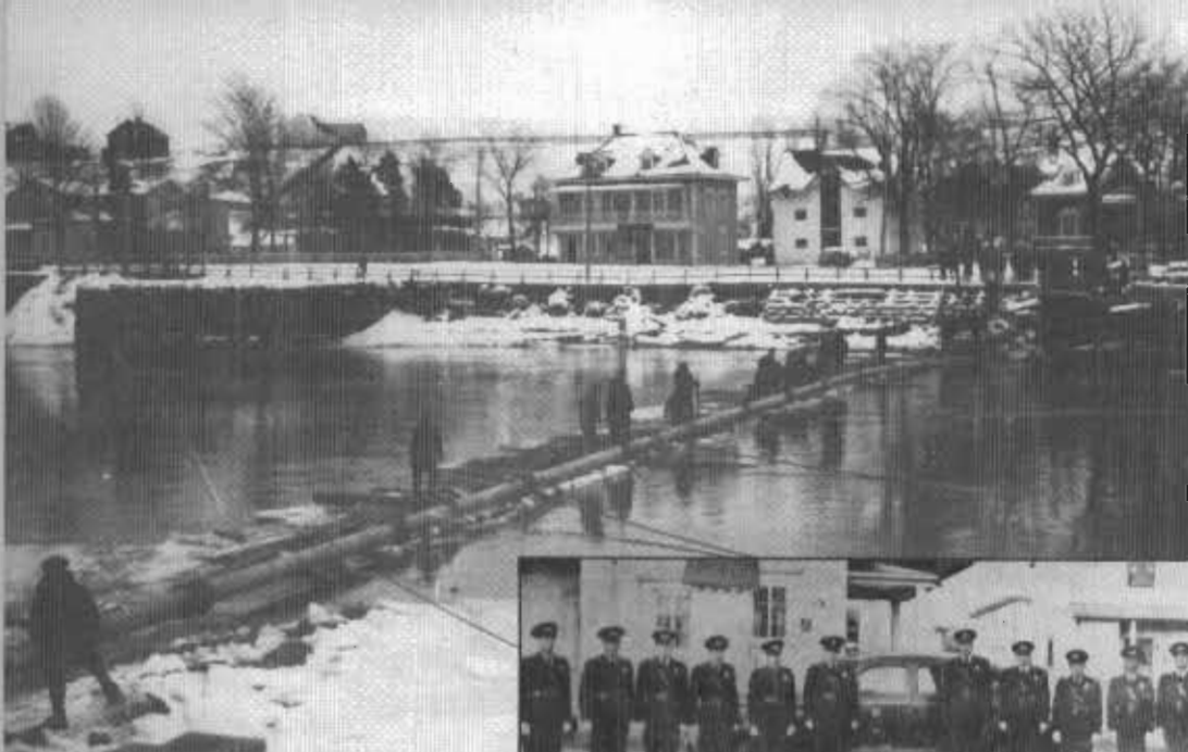
1- Pose du 1er tuyau d'aqueduc sur la rivière Matane sous la surveillance de M. Wilfrid Vézina.
