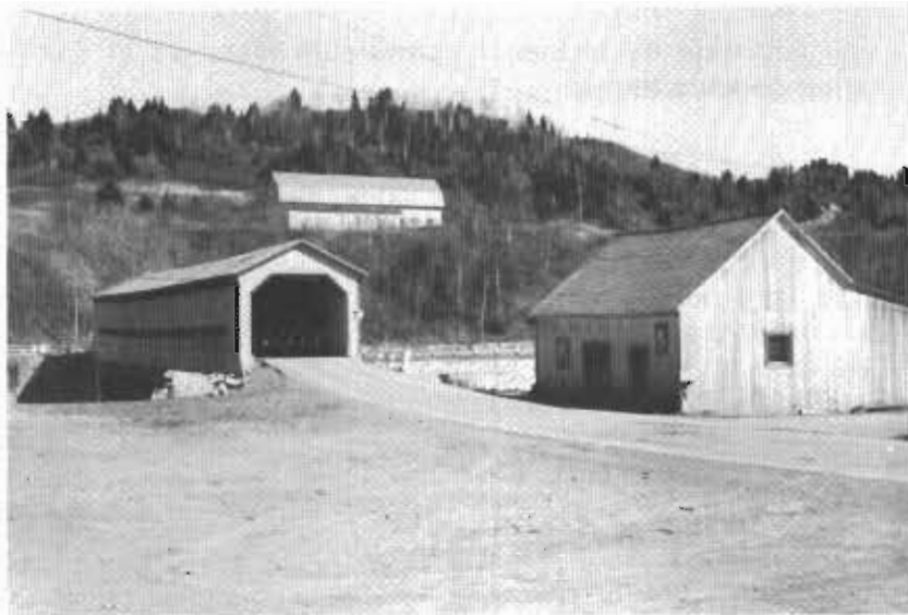
La vieille fromagerie et le pont Durette au Grand-Détour.
