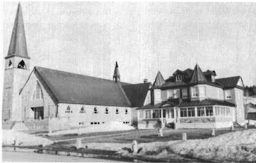
Nouvelle église, presbytère rénové.
