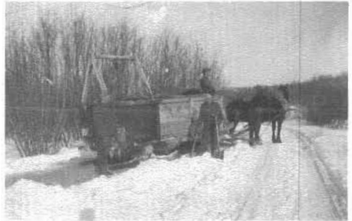
*Réservoir d'eau servant à glacer les routes pour faciliter le transport.*
