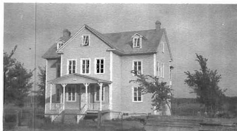
École n°. 7, rénovation terminée devenue le premier couvent
