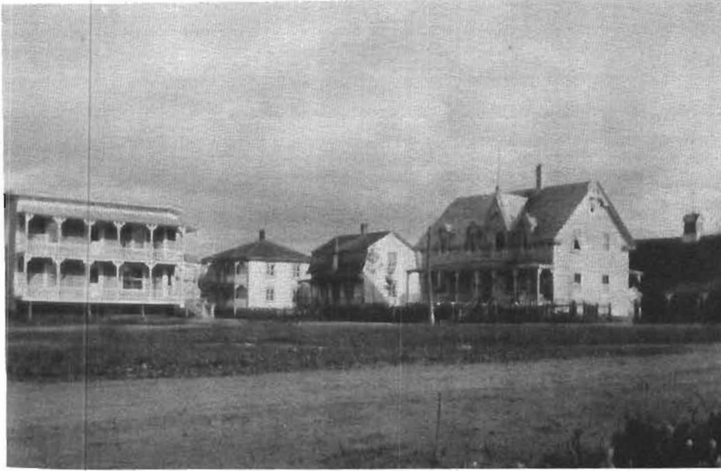
Une partie du village avant l'incendie de 1939
