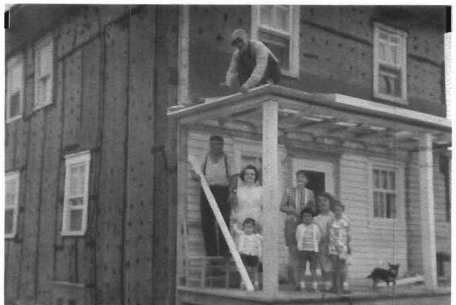
Maison en réparation
