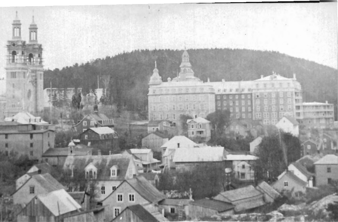
Sainte-Anne-de-la-Pocatière en 1919. Remarquez les échaffaudages du clocher.
