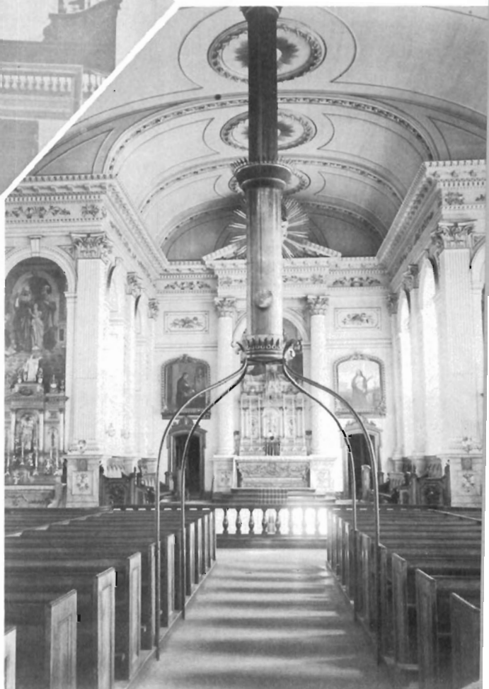
Intérieur de l'église de 1846 à 1917. Photo prise vers 1900.
