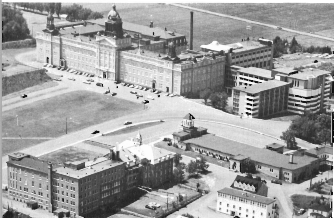
Le collège, le sous-bassement et le couvent en 1965.
