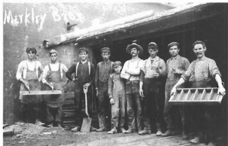
En 1920, les employés de la briqueterie Merkley Brothers avec les outils de leur métier: pelle, truelle à deux poignées, moules à briques d'argile. Nous avons pu en identifier quelques-uns. Dans l'ordre habituel: Isaïe Rainville, un inconnu, Napoléon Rainville, deux inconnus, Arthur Léger, Audile Drouin, Emery Boisvenue et un certain Pilon.
