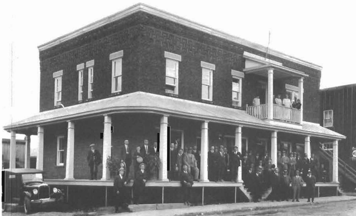
Photo de 1926 environ, de l'actuel Hôtel Nation qui s'appelait Hôtel Russell quand le père de René Boiteau en était propriétaire. Elle a depuis lors perdu ses perrons et toitures de perrons. Tout à fait à droite, le magasin général Joseph Carrière qu'il vendit plus tard à Hormidas Dicaire et ensuite à Willfrid Ranger.
