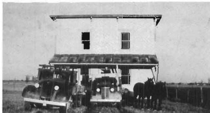
Pour déplacer la maison de Roméo Racine: atteler deux chevaux (encore ceux-là!) et deux camionnettes.
