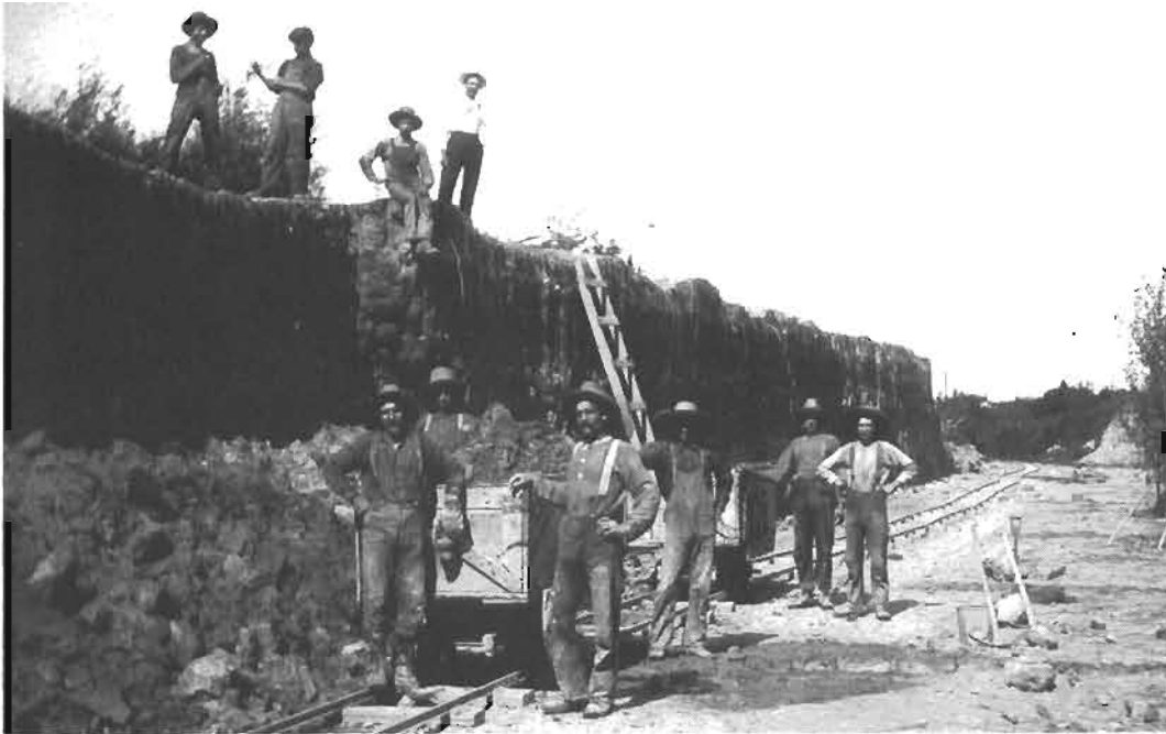
En 1903, employés de la briqueterie Merkley Brothers de Casselman, recueillant l'argile nécessaire à la fabrique où l'on moulaît et cuisait le produit. A force de retirer de l'argile, on créait des falaises artificielles. Le seul qu'il nous fut possible d'identifier, c'est celui de l'extrême gauche: Pierre Duquette.
