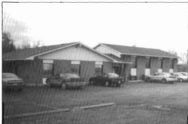
BDO Dunwoody Comptables agréés et consultants. Ces bureaux construits en 1979 furent agrandis en 1984.
