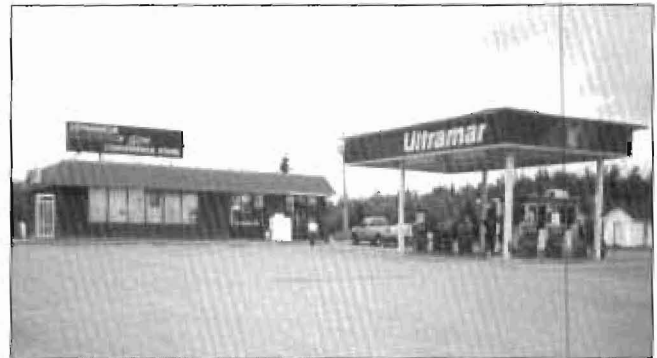
Le dépanneur Gem et station-service Ultramar au coin de la 3e concession.
