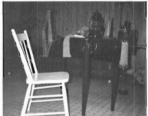
La tricoteuse de Mme Léose Gendron; à gauche le porte-laine, le bobinoir activé par une manivelle. La bobine de laine fournit la tricoteuse munie d'aiguilles; le poids tire sur le bas à mesure qu'il allonge. Le "fanal" à gaz produisait un meilleur éclairage que la chandelle. Photo : Simone Gendron-Guindon.
