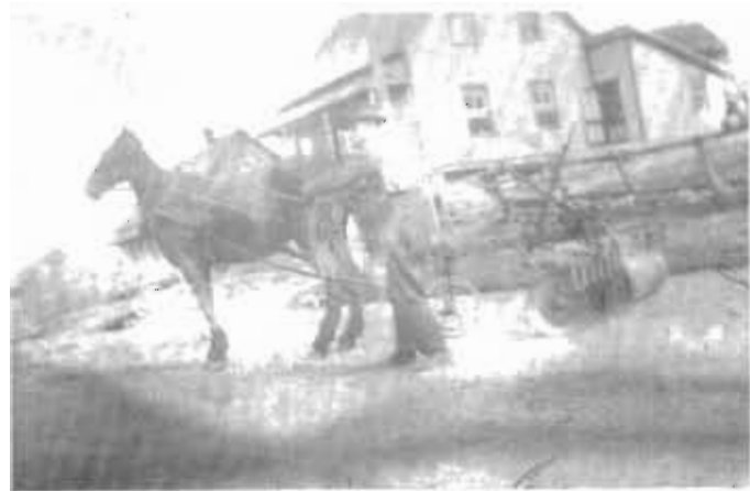
On travaille la rue en face de la maison des David
