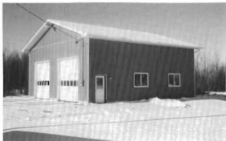
Garage construit 1987 pour entretien des machines Bernard transport et excavation
