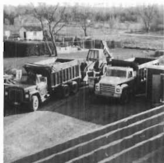
Machineries de Bernard transport et excavation
