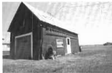
Cette remise bâtie avec les pièces de la 1 ère chapelle, servait d'endroit pour garder les cercueils
