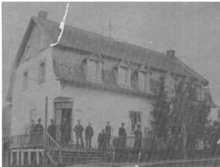
Maison de Wilfrid Thivierge qui contenait le magasin général et le bureau de poste
