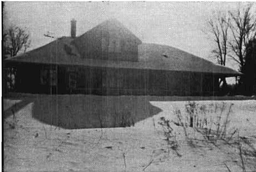
L'ancienne gare de Bourget
