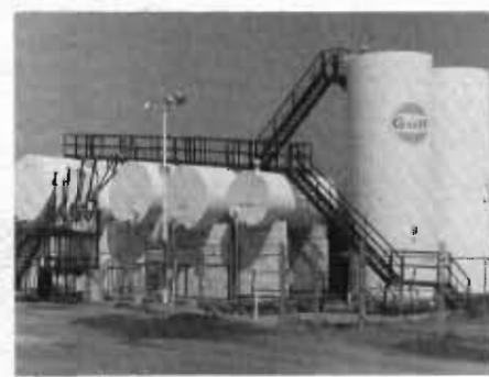
Réservoirs d'entreposage près de la voie ferrée.
