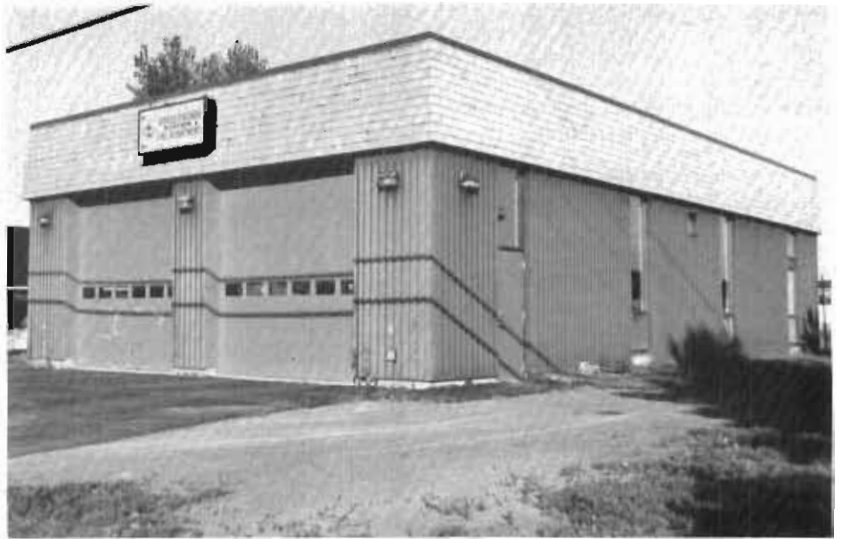
Poste du service des incendies, sur la rue Laval-ouest.
