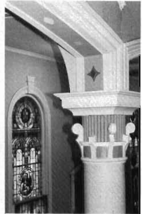
Arc angulaire supportant la voûte de l'église. (Photo: Ch.-A. H.)
