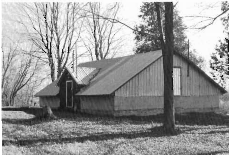
Réservoir où l'on accumule des stocks d'eau au terrain des sources.
