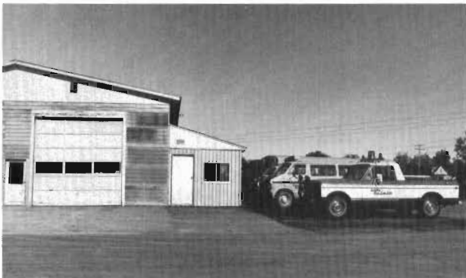
Garage de Leroux Bus Line Ltd. (Photo: Ch -A. H.)
