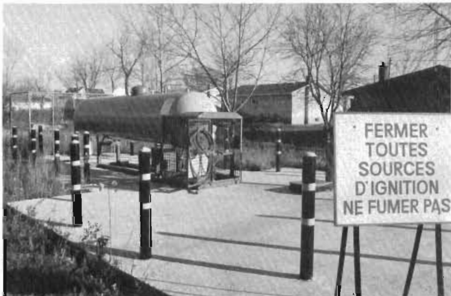
Service de propane à l'arrière du garage.
