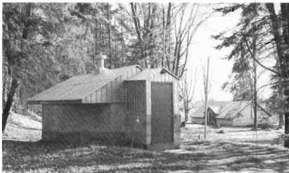
Puits où aboutissent les drains du terrain de l'aqueduc. (Photo Ch.-A. H.)
