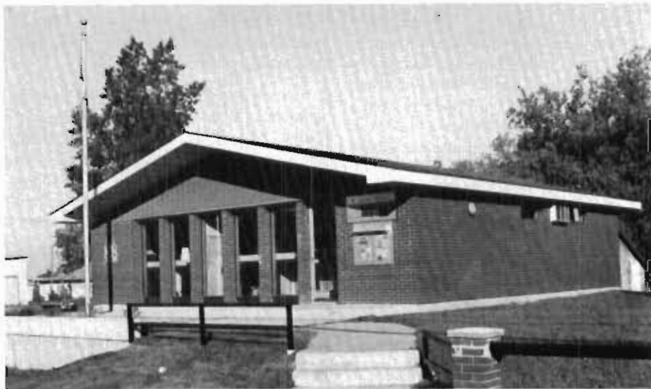
Bureau de poste de Bourget
