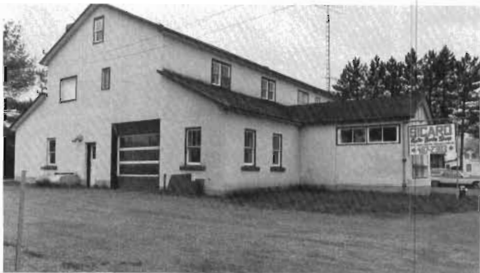
Atelier de débossage dans l'ancienne fromagerie.
