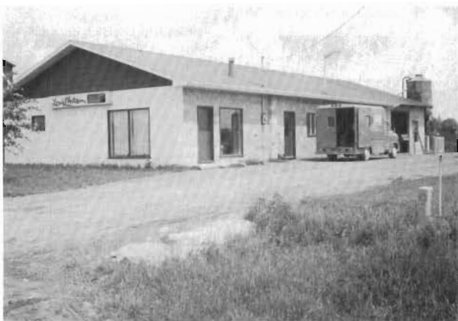
L'Usine de Louis l'Artisan avant la dernière addition.
