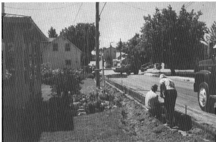
On remplace l'ancien trottoir - 1989
