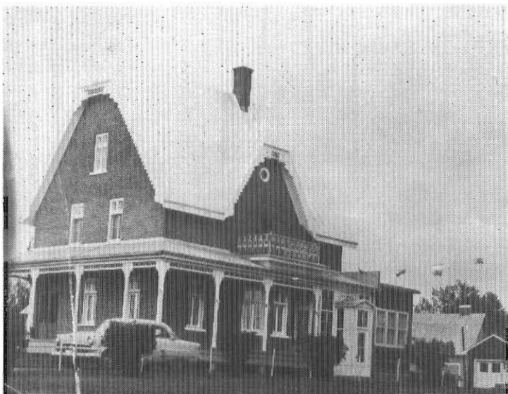
Le presbytère The rectory - 1955
