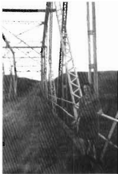
2 e pont près du village de Lemieux 1935-1979 A remarquer le tablier du pont fait de planches
