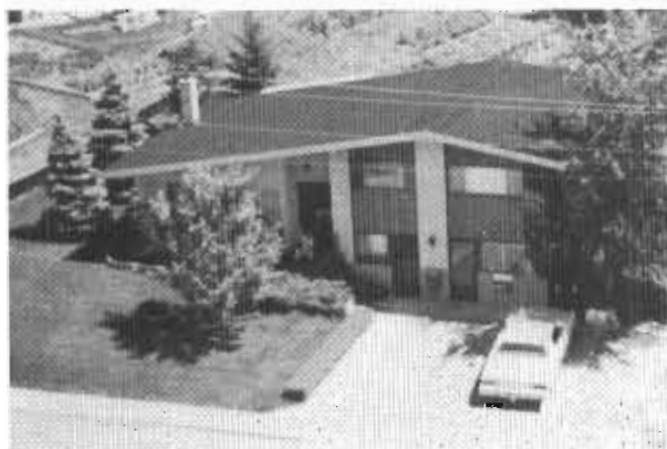
Bureau de poste
