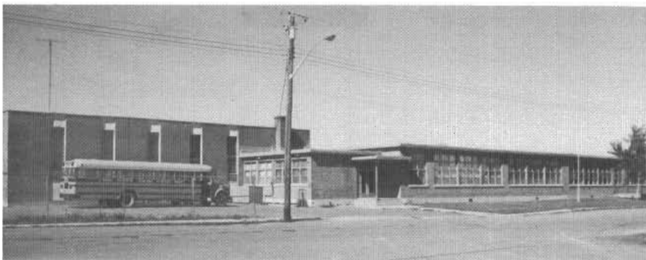
École Saint-Joseph actuelle, construite en 1961
