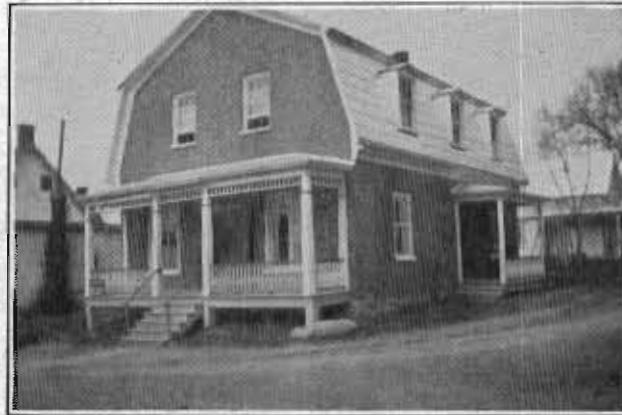
Le Bureau de Poste actuel
